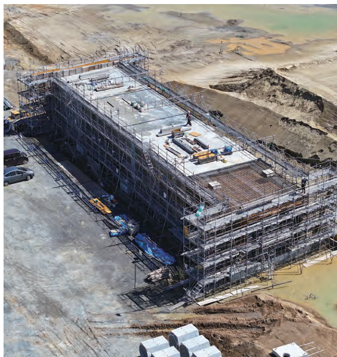
▲厩舎と周回コースを繋ぐためのボックスカルバート(暗渠)
