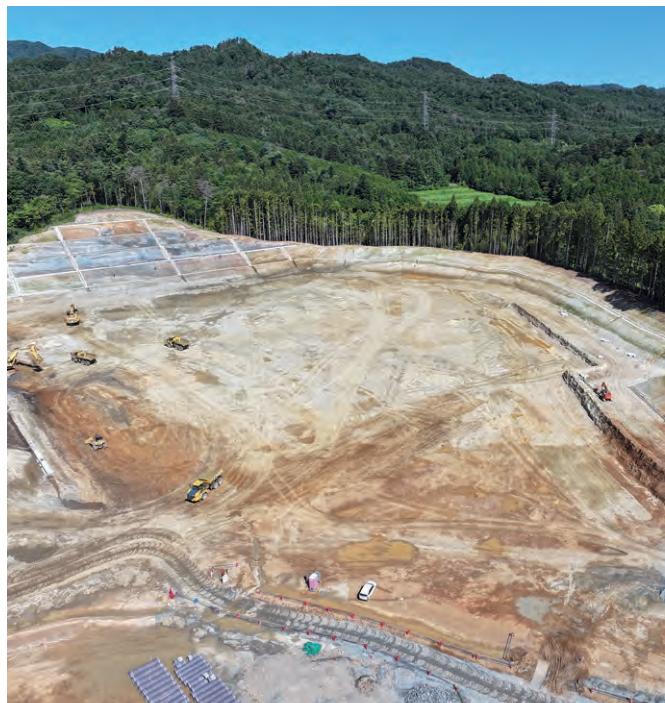
▲厩舎建設エリア 2027年5月には16棟(512馬房)の厩舎が完成する予定で工事が進められています。
